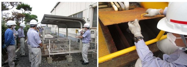
地震発生時、油水分離槽の排水不具合により分離槽から排水が溢れだした場合を想定。
